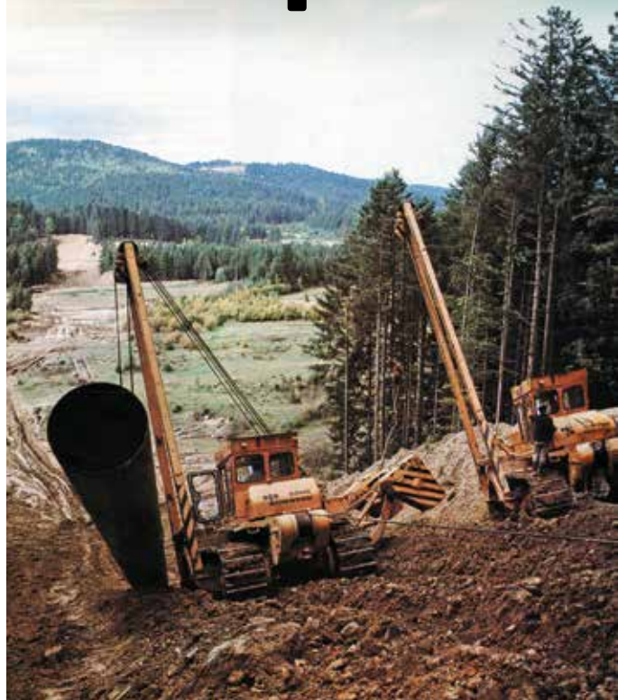
Строителям пришлось столкнуться со сложными рельефными участками трассы.
